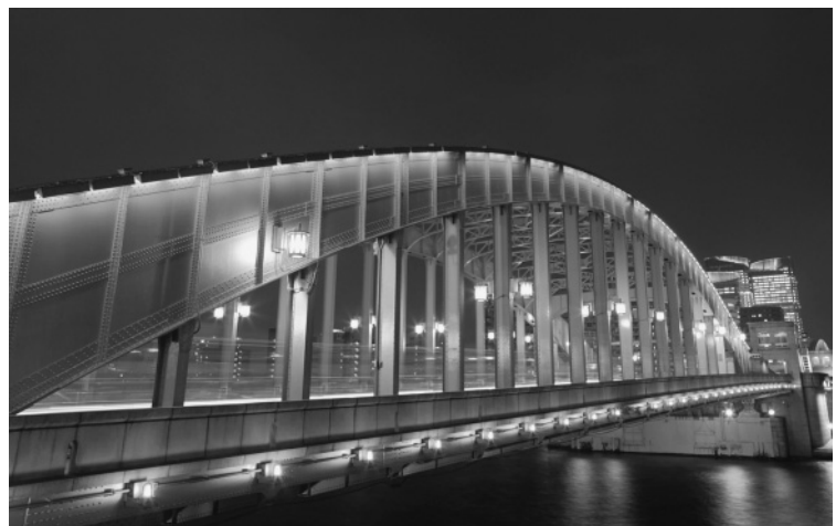
ライトアップされた勝鬨橋
